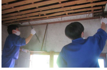
天井の板と梁（はり）を解体する様子
