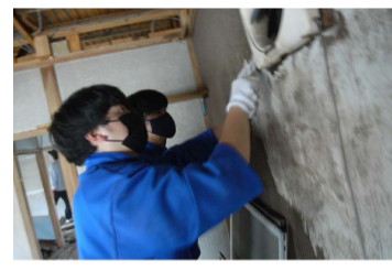
壁表面の素材を剥がす作業の様子
